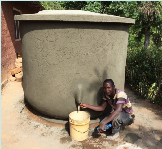
Afgeronde calabash tank op locatie
