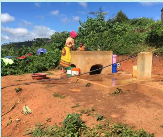
Beeld van de openbare kranen met wastafels die ook in Makanya gerealiseerd gaan worden.
