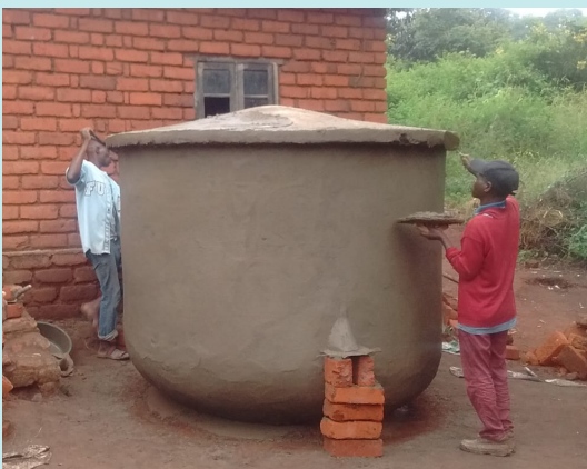
afwerking calabash tank door metselaars
