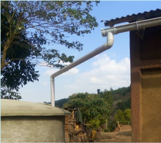
verbinding regenpijp tussen dak en tank
