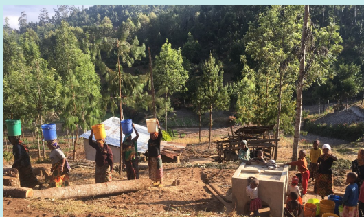
Beelden van de aanbouw in Ndadwe
